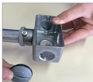
Introduzir as juntas de vedações roscada no condulete.
