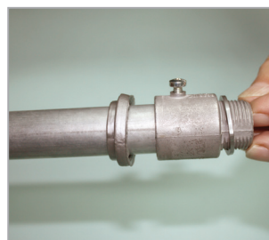
Introduzir o eletroduto no conector e apertar parafuso.
