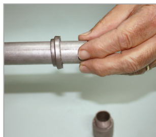
Introduzir a junta de vedação no eletroduto.
