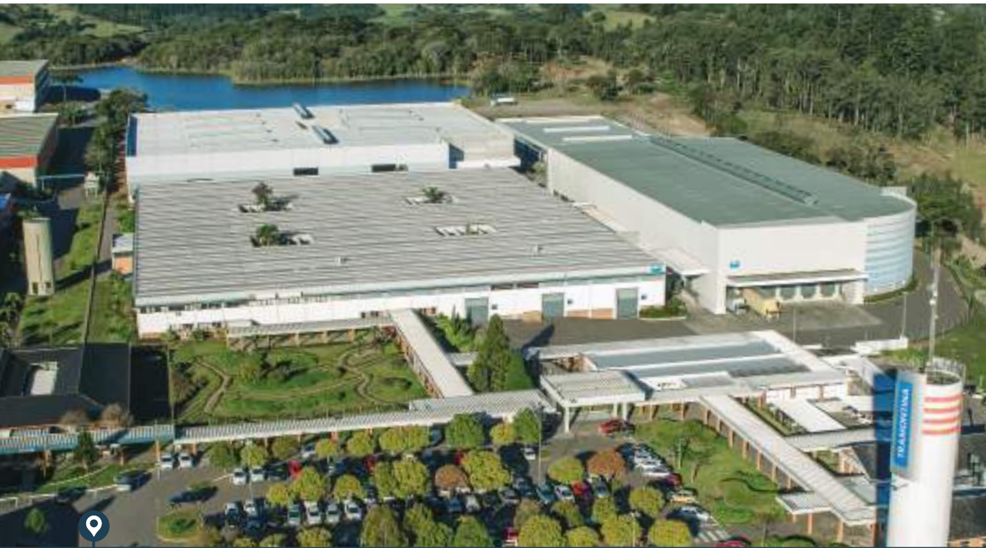
ELETRIK Manufacturing Unit | Unidad de fabricación de ELETRIK
